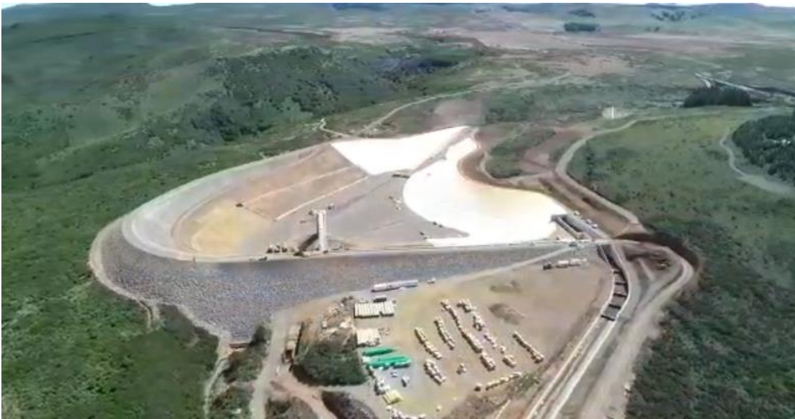
Figura 8: Imagem aérea das obras
