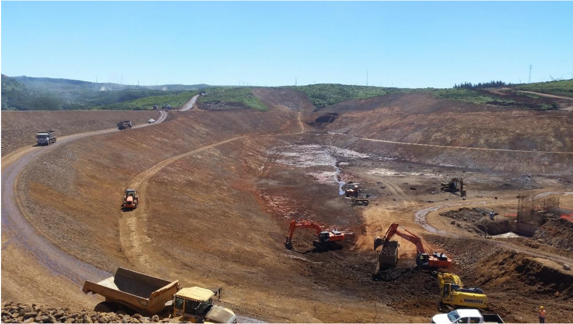
Figura 7: Construção da estação elevatória
