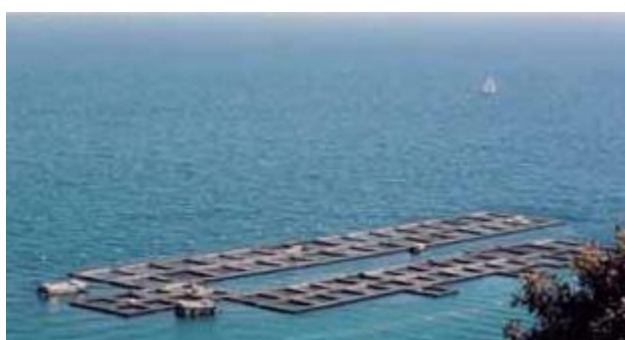
Fig. 55 - Aquacultura usando ECOs flutuantes construídas com componentes Jetfloat (Cannes França) Fonte FAO 498
